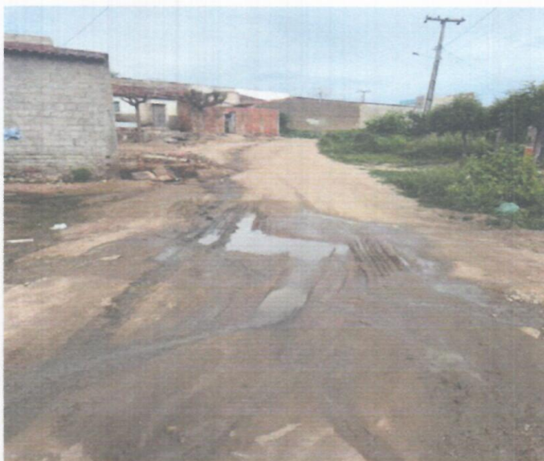
Imagem 6 - RUA ARGEMIRO JOSUE DA COSTA
